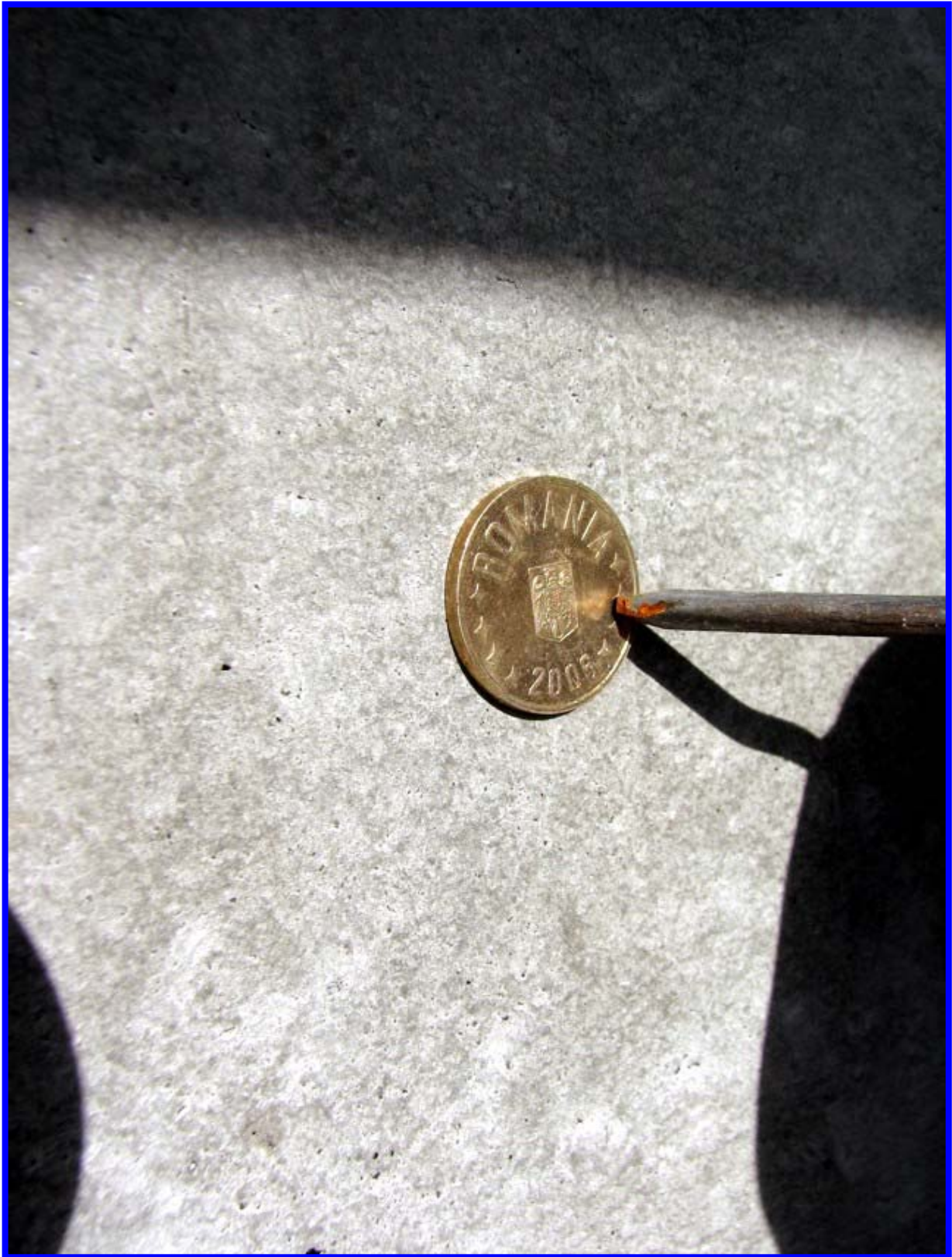
Finețea suprafeței de beton autocompactant după decofrare.
