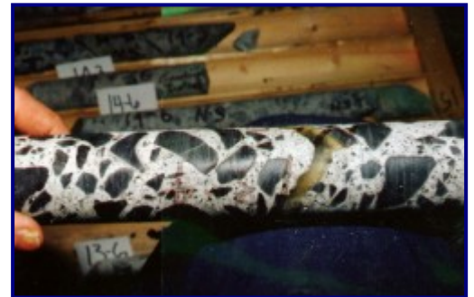
Carotă extrasă din zona injectată.
