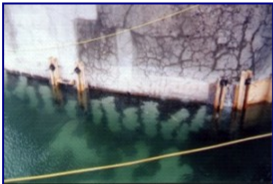
Injecții efectuate sub apă la pilele de pod.
